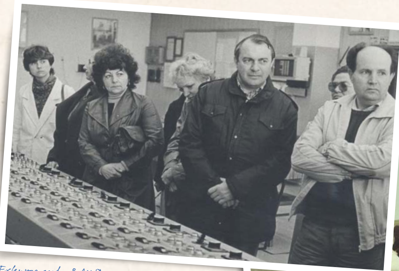
Exkurze geologů MND na podzemní zásobník plynu Hrušky
