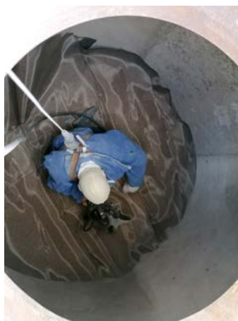
Plnění adsorbčních kolon silikagelem
